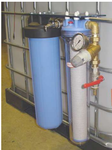
Abb.5: Filterarmatur zum Schutz vor Korrosions- Schmutzschüben, einbaufertig zur Selbstmontage.
